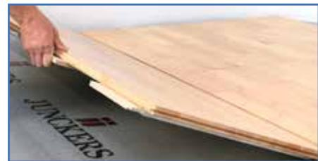
Unión de cada panel fácil y segura mediante fijaciones metálicas pre-instaladas en fábrica.
